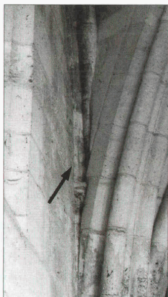
Fig. 11 et fig. 12. Jonction des formerets et des arcs. Cl. Denis Rolland, 2002.
