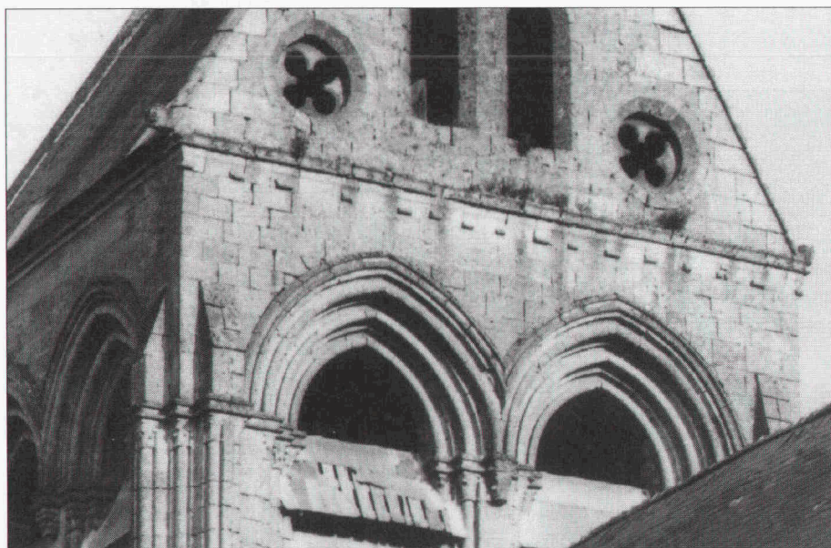
Fig. 36 et 37. Les deux pignons du clocher en 1914. En haut, pignon refait au XIV e siècle en le simplifiant légèrement : corniche, chapiteaux mais l'angle gauche n'a pas été modifié. En bas, pignon du XIII e siècle. La corniche est à modillons mais à gauche, elle est différente et identique à celle du pignon est. Les chapiteaux sont à crochet. Coll. Société historique et archéologique de Soissons.
