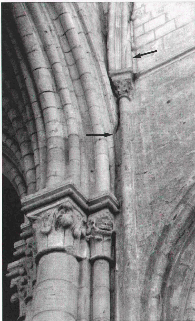
Fig. 10. La moulure externe de l'arc triomphal a été entaillée pour laisser le passage à la colonnette supportant les voûtes. L'arc diagonal vient intercepter la colonnette de l'arc et conduit à une jonction maladroite. Cl. Denis Rolland, 2002.
