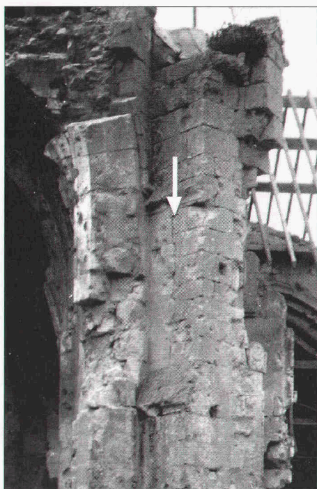
Fig. 29. Vue de profil de ce contrefort montrant le collage de maçonnerie sur un ancien contrefort. Coll. Société historique et archéologique de Soissons.
