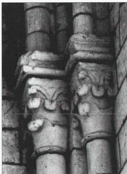
Fig. 23. Le chapiteau central a été entaillé sur la droite pour laisser le passage de l'arc diagonal (F du plan). Cl. Denis Rolland, 2002.
