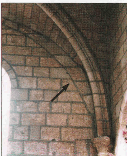
Fig. 13. Remplissage de l'engravure des voûtes anciennes. Cl. Denis Rolland, 2002.
