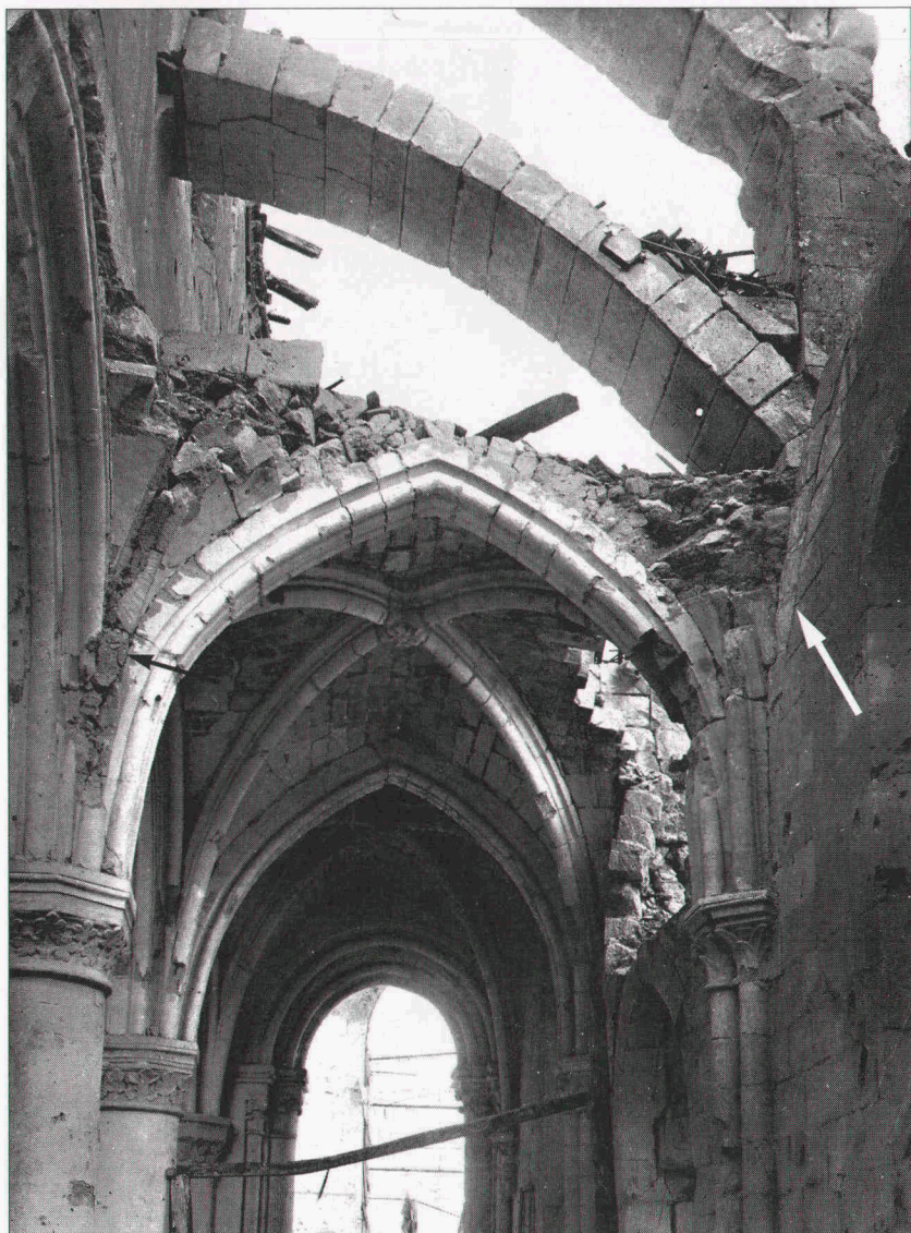
Fig. 19. La destruction du bas-côté par un obus a mis au jour le deuxième lit d'arcs-boutants qui, avant 1914, était masqué par la toiture et que l'on a rendu apparent lors de la restauration. L'arc avait été aminci au point qu'il ne subsistait que l'intrados. Il n'avait donc plus d'utilité.
