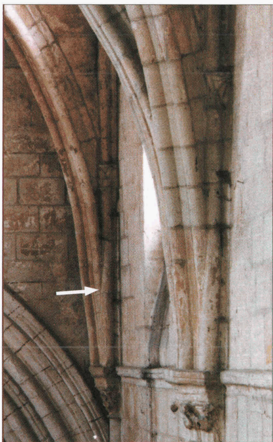
Fig. 11 et fig. 12. Jonction des formerets et des arcs. Cl. Denis Rolland, 2002.
