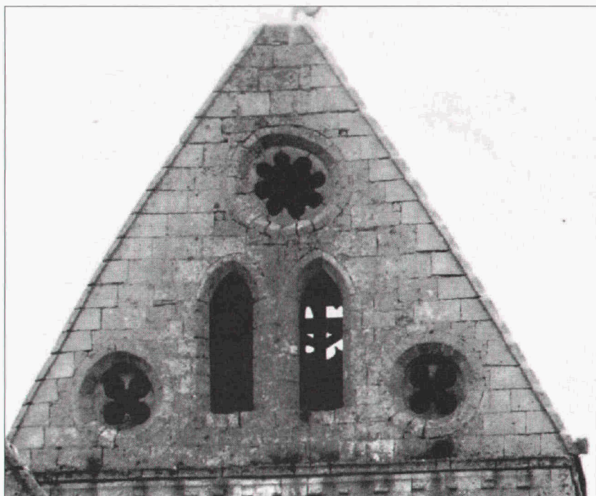
Fig. 39. Détail de la pointe du pignon ouest du clocher en 1914. On voit que seule la partie centrale est ancienne. Les deux rampants ont été refaits. L'oculus haut a été refait dans sa partie inférieure gauche. Coll. Société historique et archéologique de Soissons.
