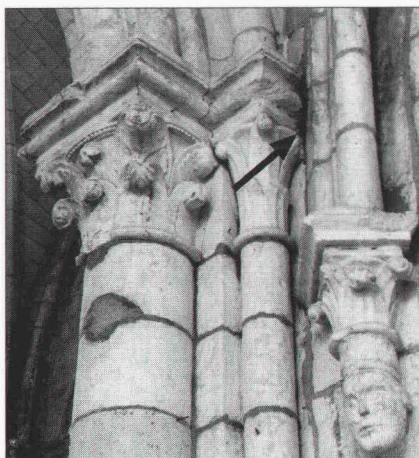
Fig. 23. Le chapiteau central a été entaillé sur la droite pour laisser le passage de l'arc diagonal (F du plan). Cl. Denis Rolland, 2002.
