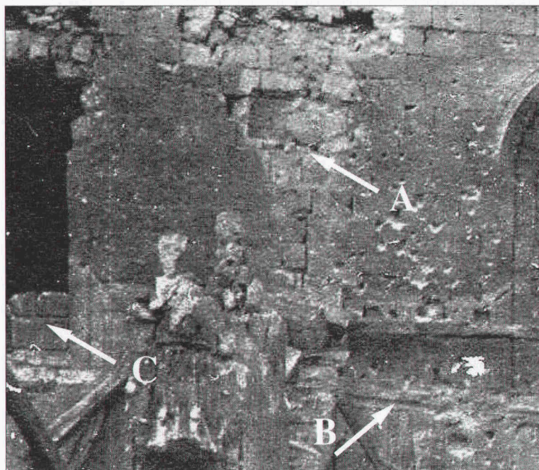
Fig. 18. La zone d'appui d'un des arcs-boutants après destruction. L'arc a été simplement engravé, en délit, dans le mur de la nef dont on voit la continuité des lits (A). A noter la trace de l'ancien niveau de toiture juste sous les baies (B) et les deux assises de remplissage sur l'appui de la fenêtre de gauche (C). Coll. Société historique et archéologique de Soissons.
